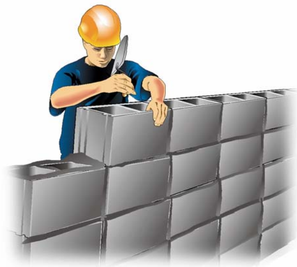
Posa a giunti verticali allineati (a sorella)
