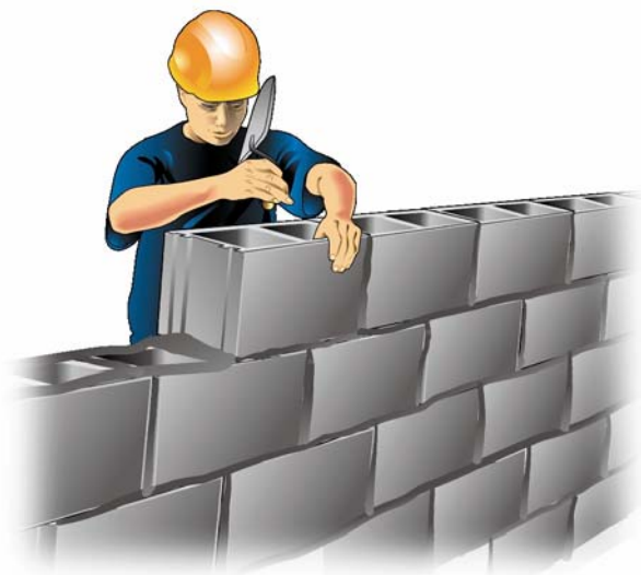
Posa a giunti verticali sfalsati
